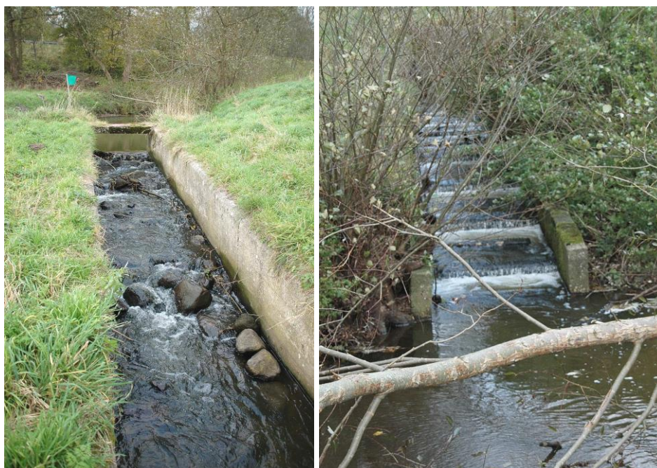
Foto 3. Stryget (tv) hæver vandet så meget, at munden af fisketrappen opstrøms (th) nu er i kontakt med vandspejlet. I årene frem til 2010 var der et fald på en lille meter fra trappen og ned på lavvandet stenbund.
